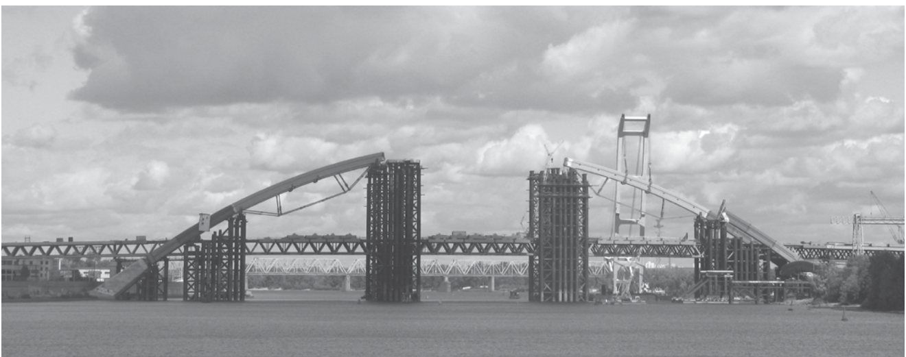
Будівництво Подільсько-Воскресенського мосту, що має з'єднати правий та лівий берег Києва, триває вже 13 років
